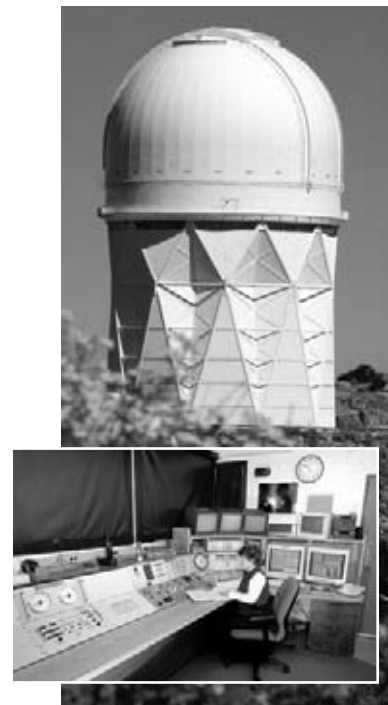
Le bâtiment du télescope Mayall 4 mètres et sa chambre de contrôle (encart)
