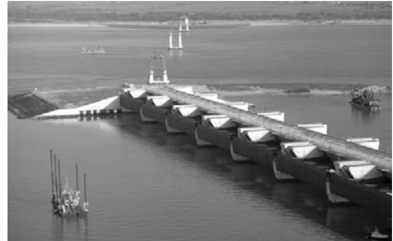
Compuertas evitan que la sobrecarga de agua inunde las tierras.
